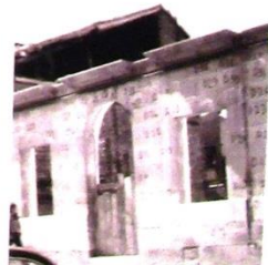
Casa del siglo XXII de la familia Escobedo que fue derribada en los años 80 y la piedra de sillares de la fachada numerada y transportada a otro lugar.
