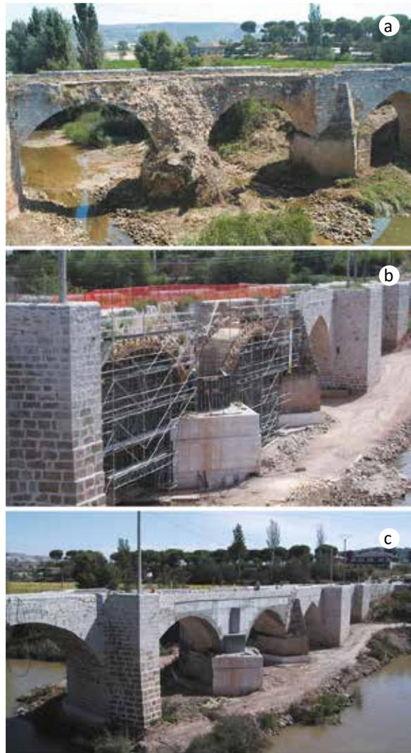
Fig. 12. a) Ruina de los arcos 4.º y 5.º, con su pilar, aguas abajo, 2005. b) Proceso de reparación de los arcos 4.º y 5.º, aguas abajo, 2006 (fotografía de Carlos Infante). c) Proceso de reparación de los arcos 4.º y 5.º, aguas abajo, 2006 (fotografía de Carlos Infante).
