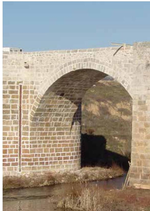
Fig. 7. Arco 7.º, renacentista, aguas abajo, 2006. Se puede apreciar la armonía de toda la estructura y una regla para marcar el nivel del agua (fotografía de Carlos Infante).
