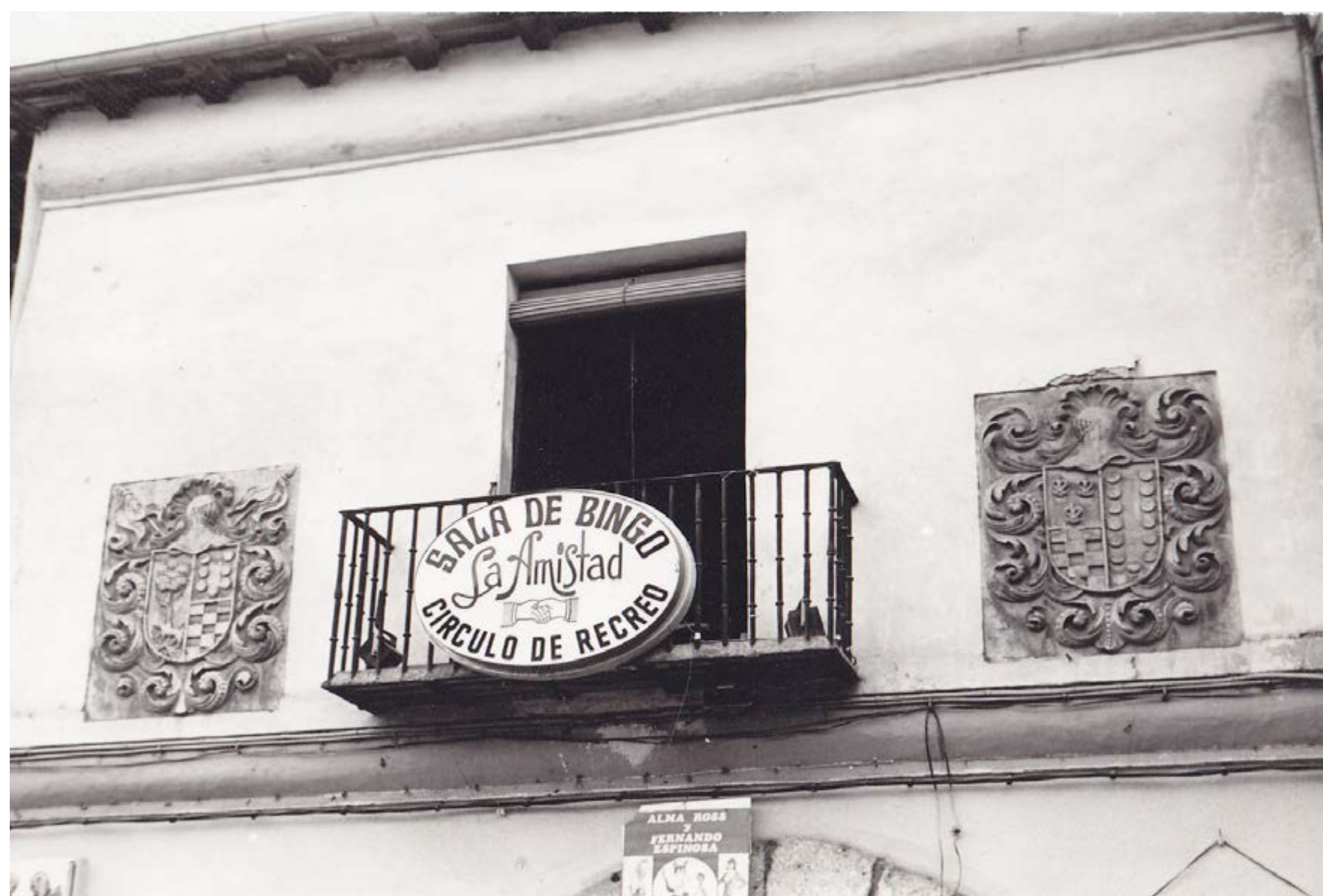
EL ÚLTIMO EMPLAZAMIENTO DEL CASINO DE LA AMISTAD, CON SALA DE BINGO; EN LA CALLE DERECHA AL COSO
