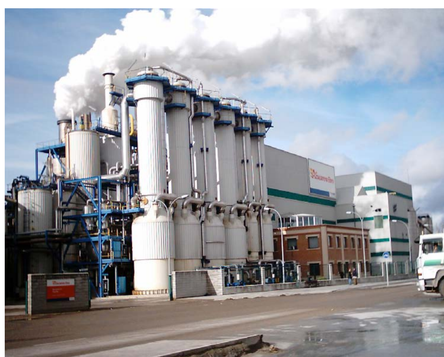
LAS CAJAS DE EVAPORACIÓN EN EL EXTERIOR.
