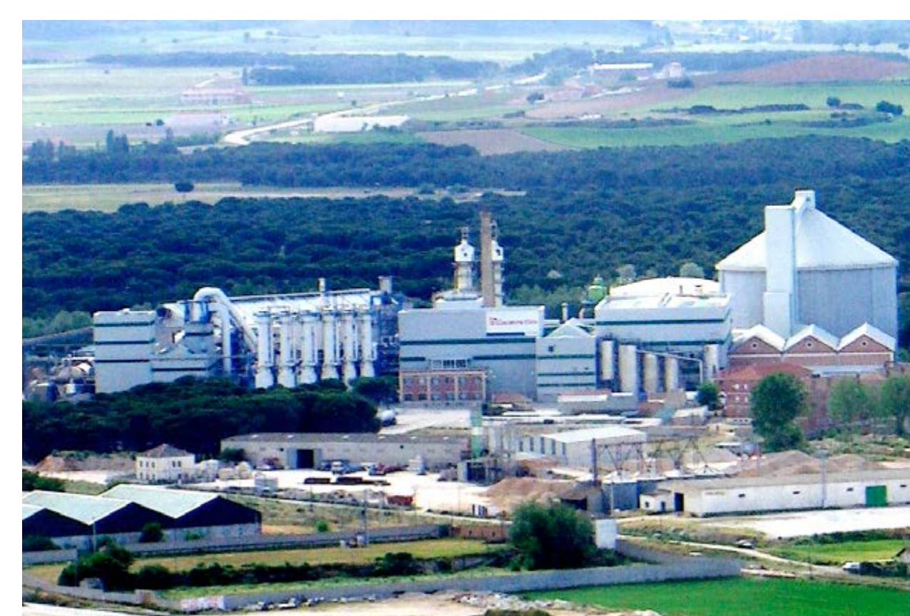
VISTA GENERAL DE LA FÁBRICA AMPLIADA (1998).
