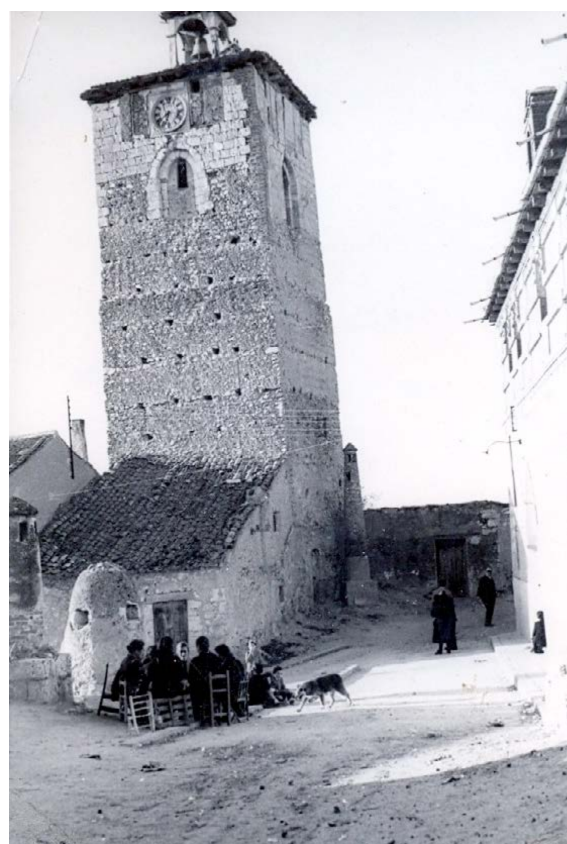
LA TORRE DEL RELOJ, UN CORRILLO EN LA CALLE Y EL ANTIGUO HOSPITAL
