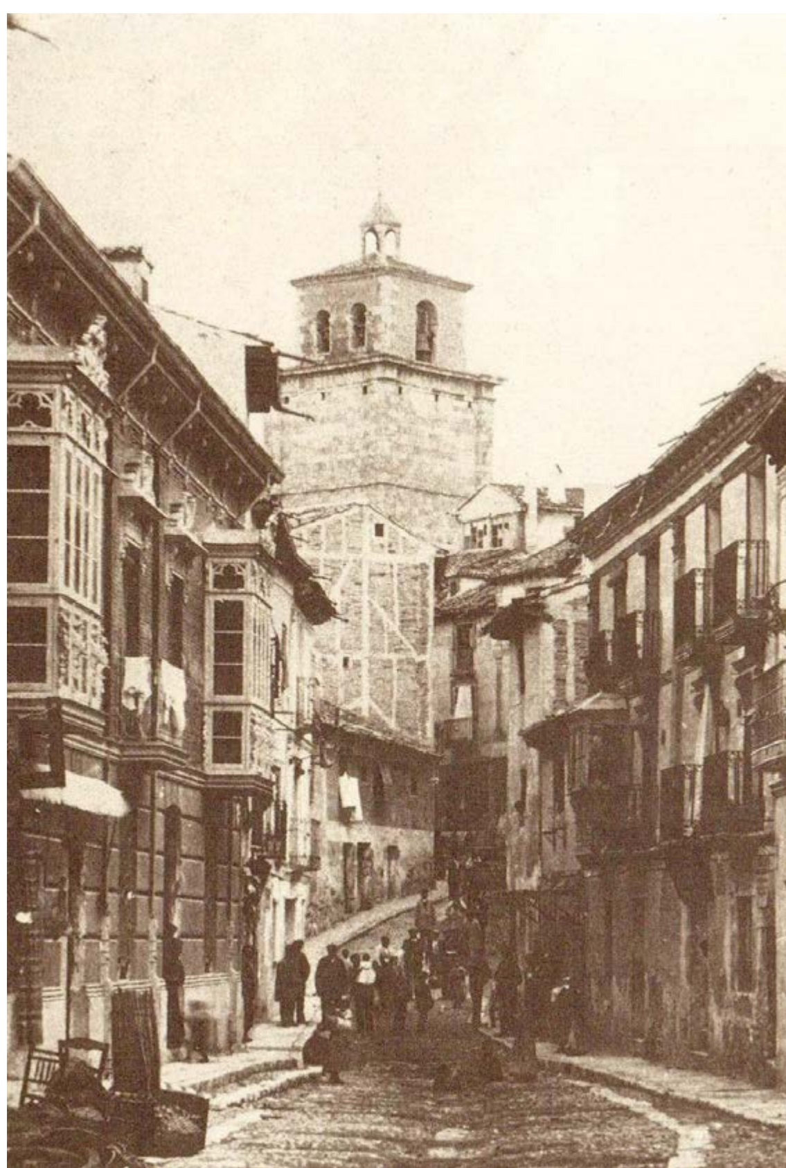
Calle de Reoyo al fondo a la derecha las antiguas escuelas y posible situación de la sinagoga del barrio judío
