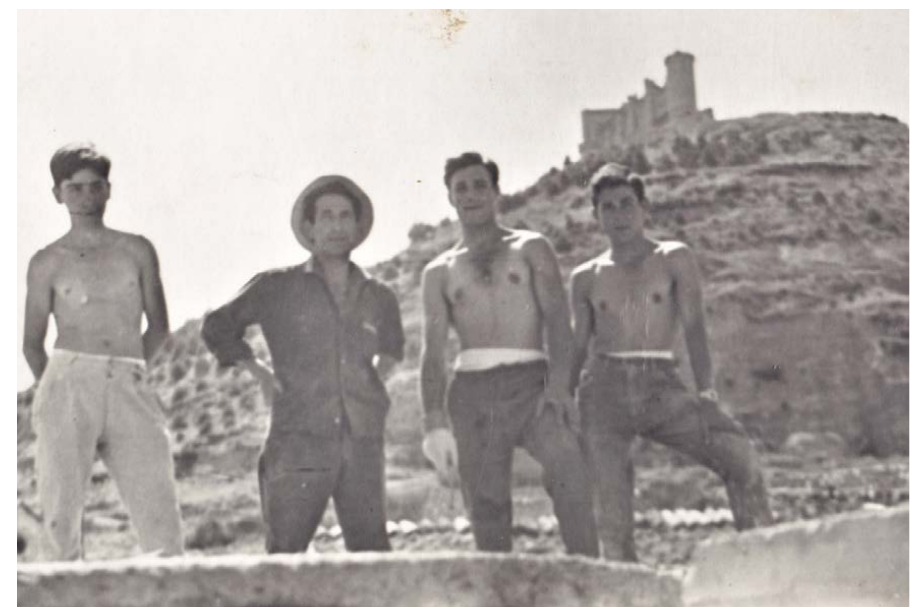
x ALBAÑILES ARREGLANDO UN TEJADO. AÑOS 60
