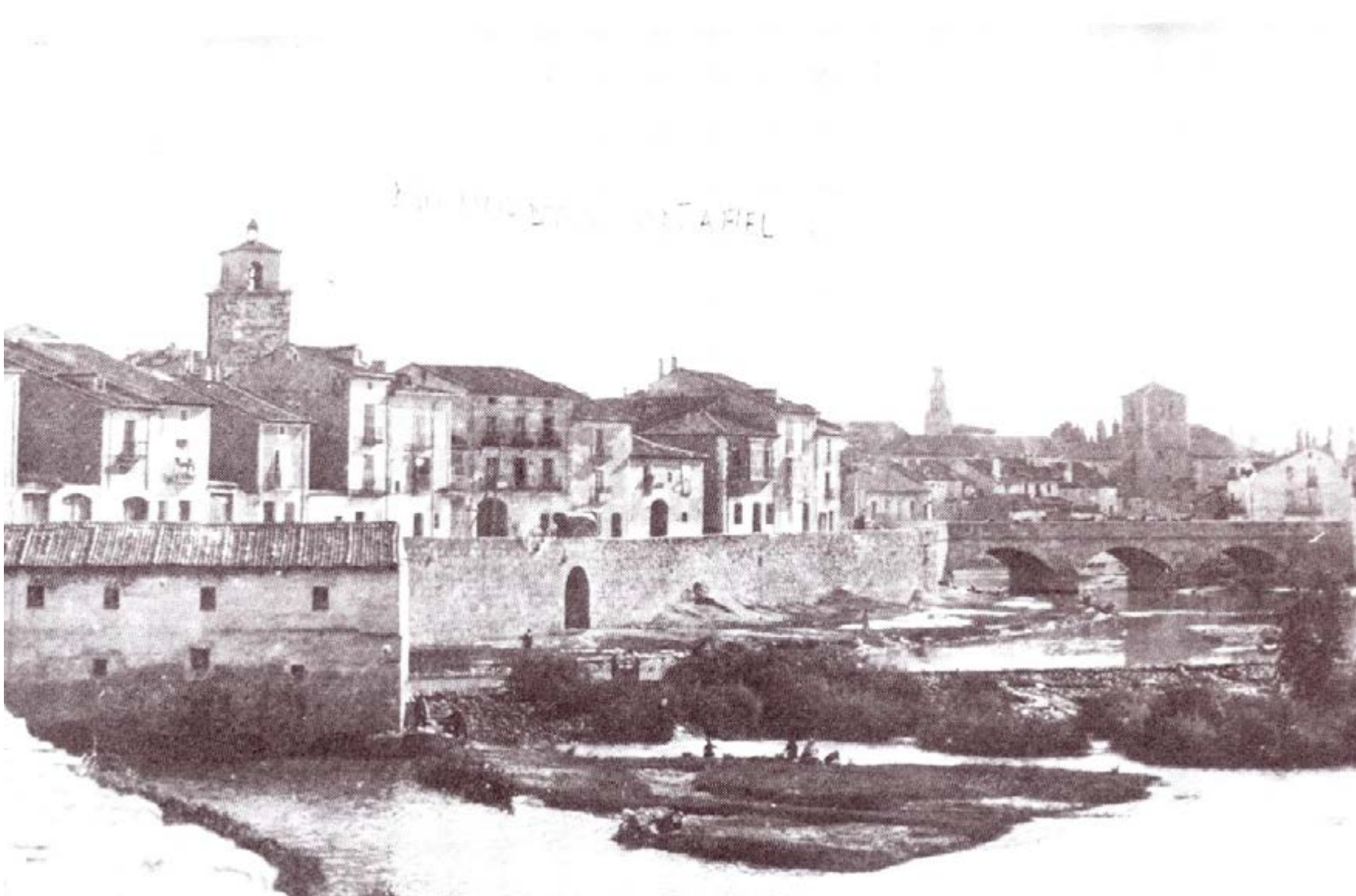
EL DURATÓN, EL MOLINO DE PALACIOS Y LA MURALLA. A PRINCIPIOS DEL SIGLO XX.
