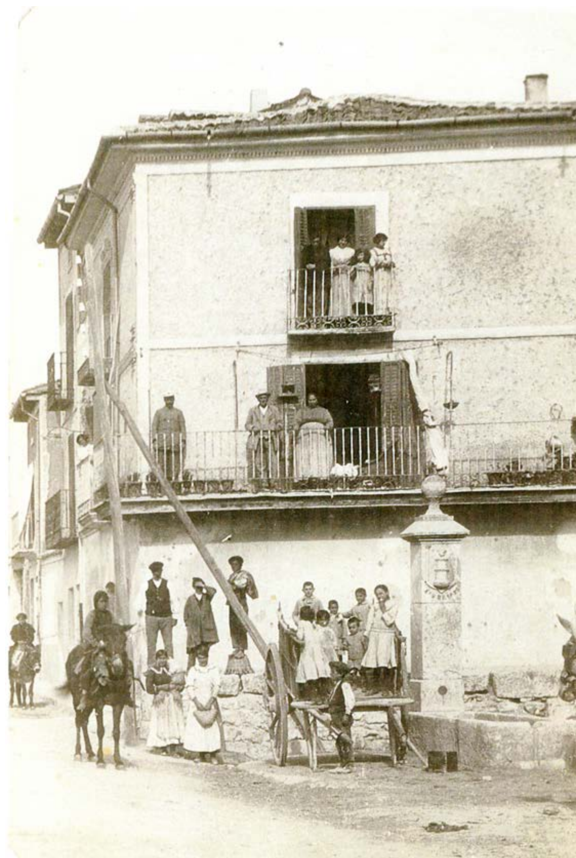
CRUCE ENTRE LA CALLE PEDRAJA Y LA AVENIDA DE LA CONSTITUCIÓN
