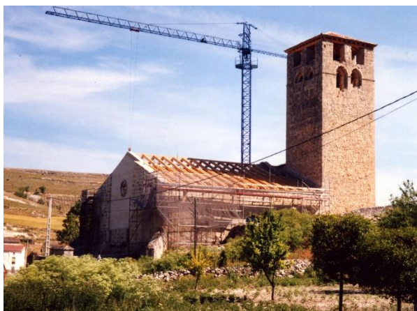
Reconstrucción de muros y cubierta. 2001.
