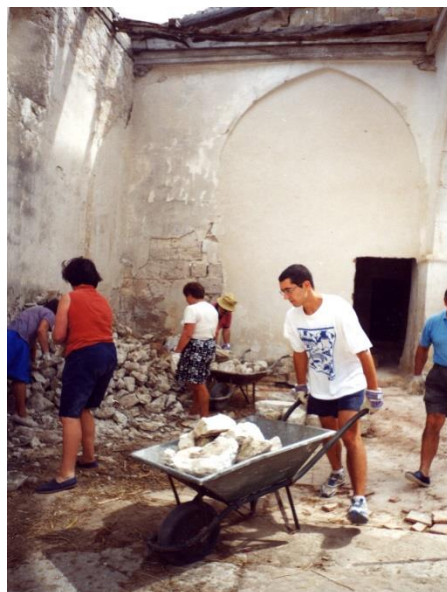
Voluntarios trabajando en el desescombros 1998
