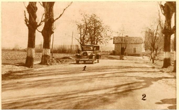
El lugar de la carretera de Valladolid a Peñafiel, donde ocurrió la tragedia, El coche que se ve en la fotografía (1) ocupa el sitio donde don Wifredo aguardaba, en su automóvil parado y con las portezuelas abiertas, la llegada de su esposa y del acompañante de esta. Y el sitio marcado con (2) fue donde el chofer Constantino Contreras que conducía a doña María y don Vicente, tuvo que detenerse ante la amenaza de la pistola que esgrimía don Wifredo.
