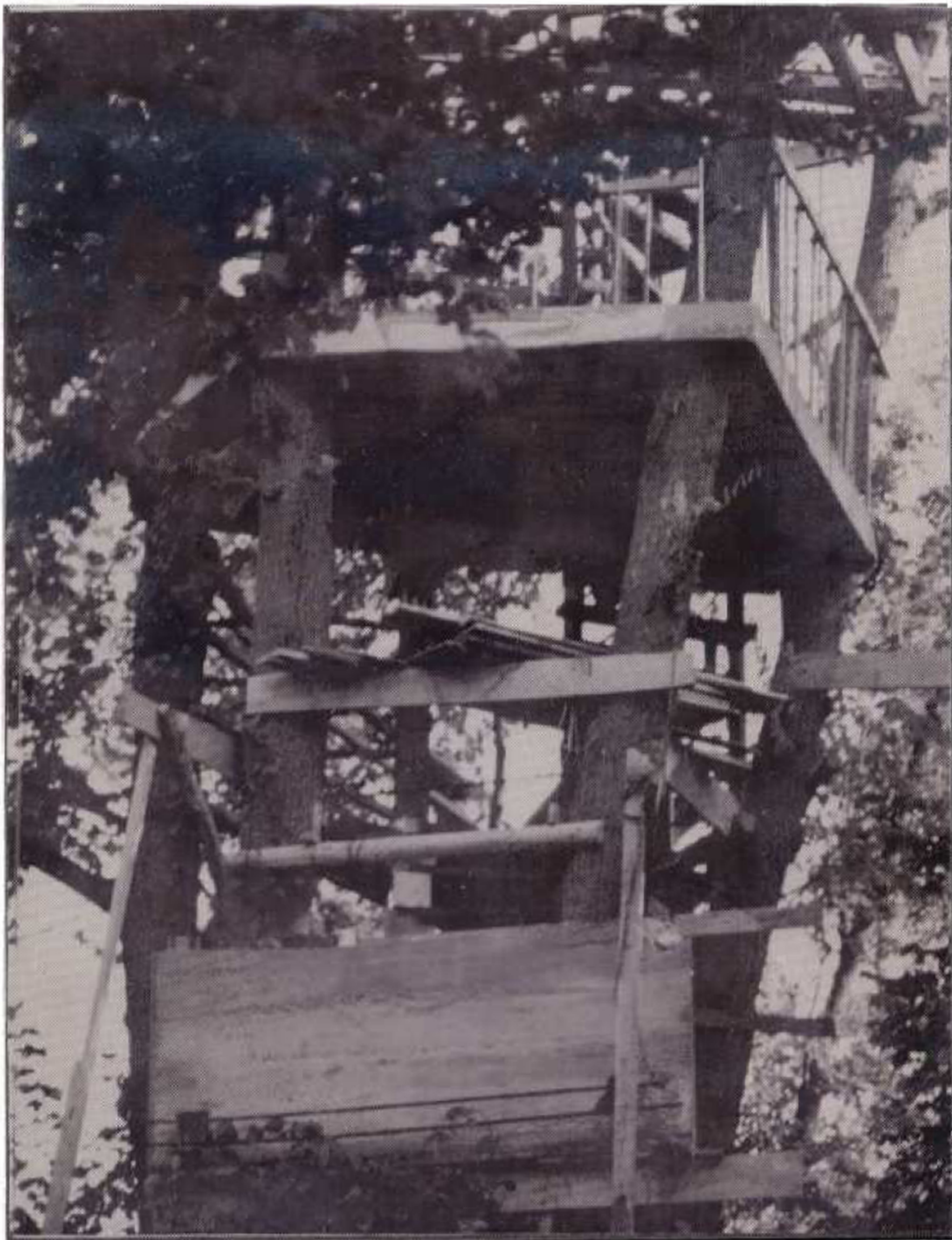
-Vista parcial de la obra todavía en construcción.
