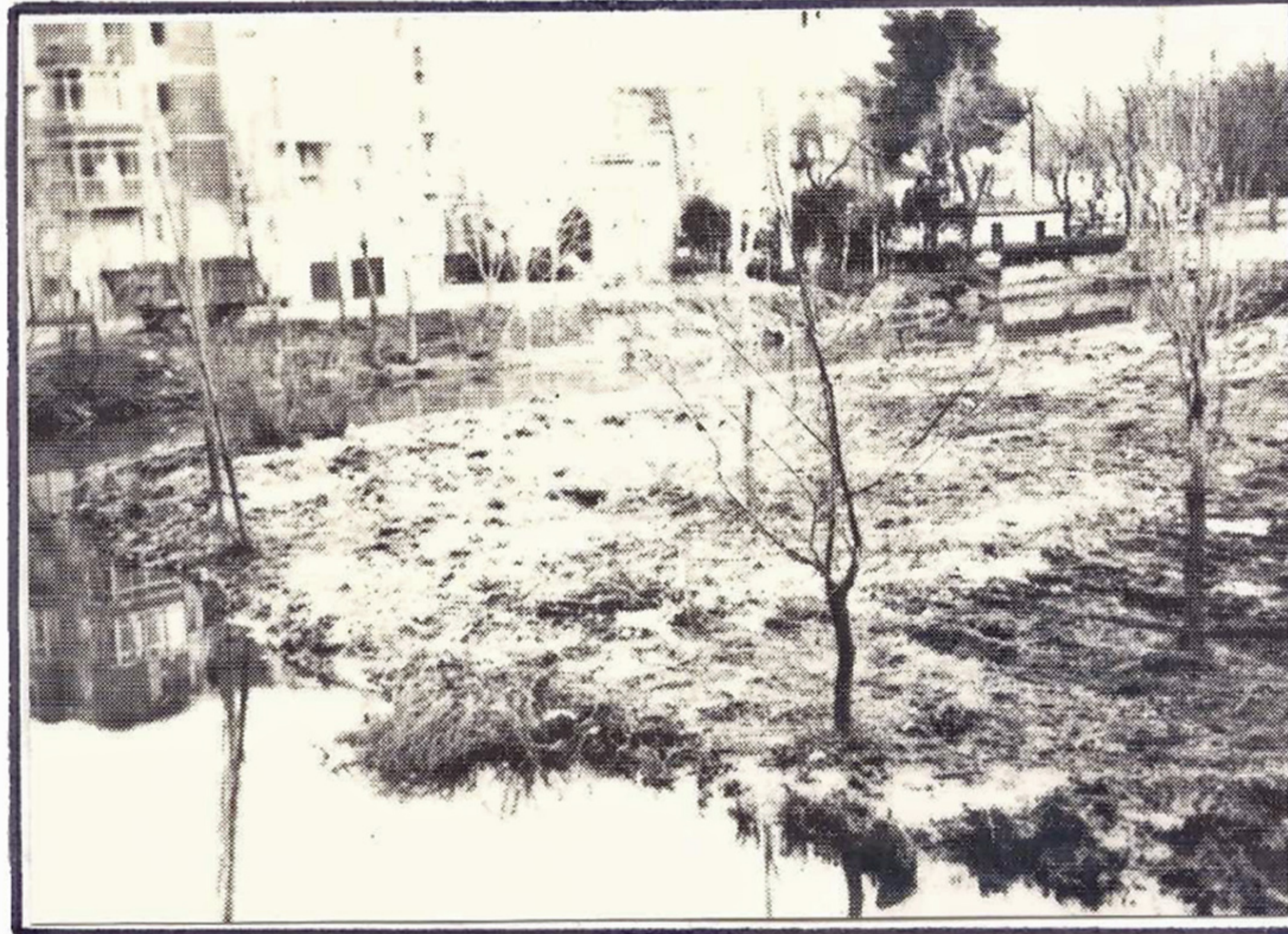
Ya se ha comenzado a hacer obras en las riberas del Río Duratón. Este es su aspecto actual.
