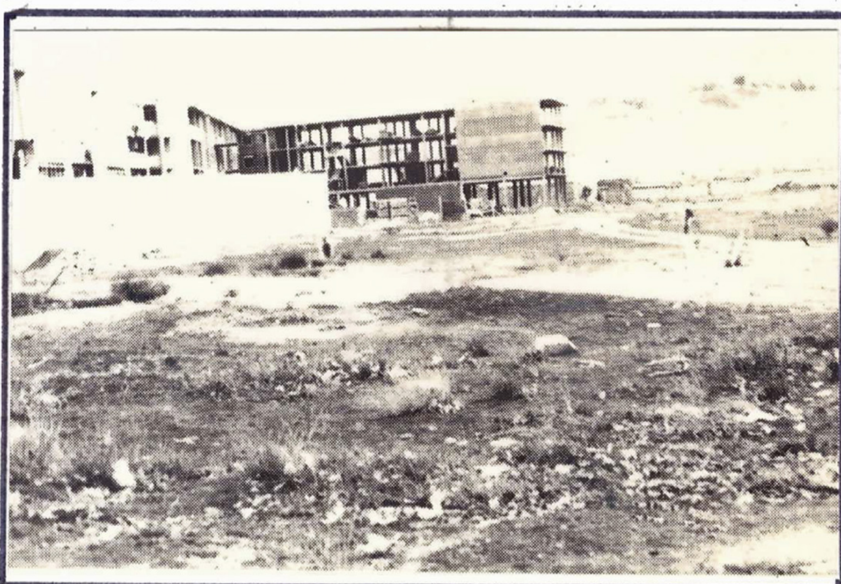
Sobre estos terrenos se construirá el Centro de Salud Comarcal.
