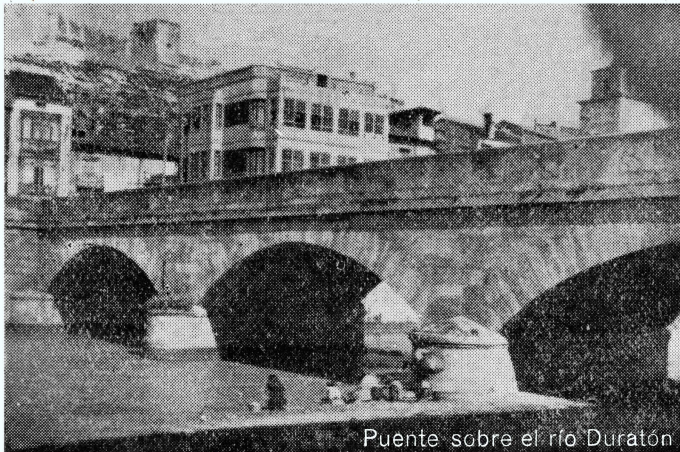
Puente sobre el río Duratón
