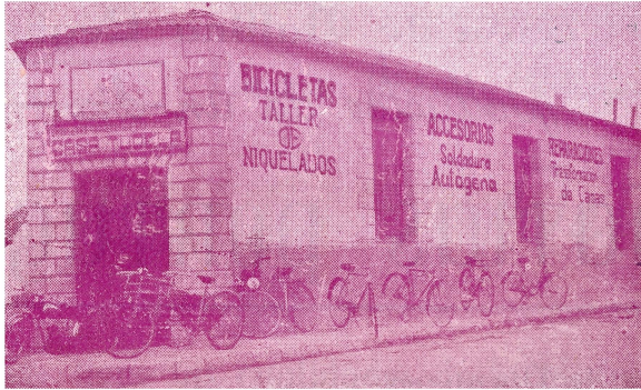
Edificio y sus instalaciones
