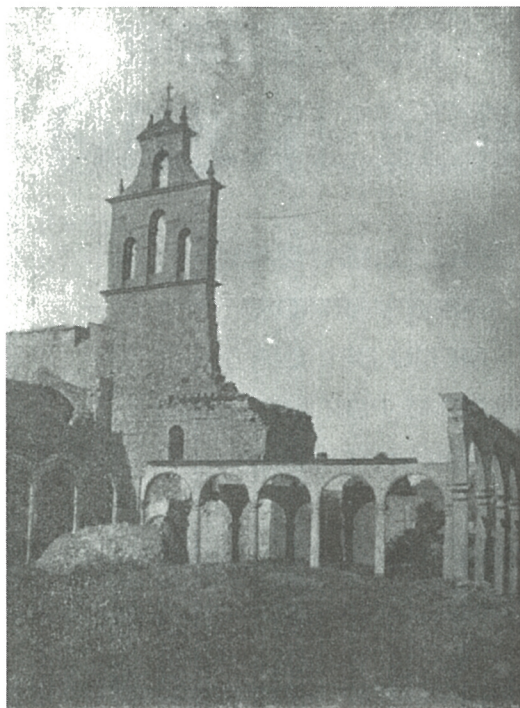
Claustro y Espadaña de San Francisco. 1905
